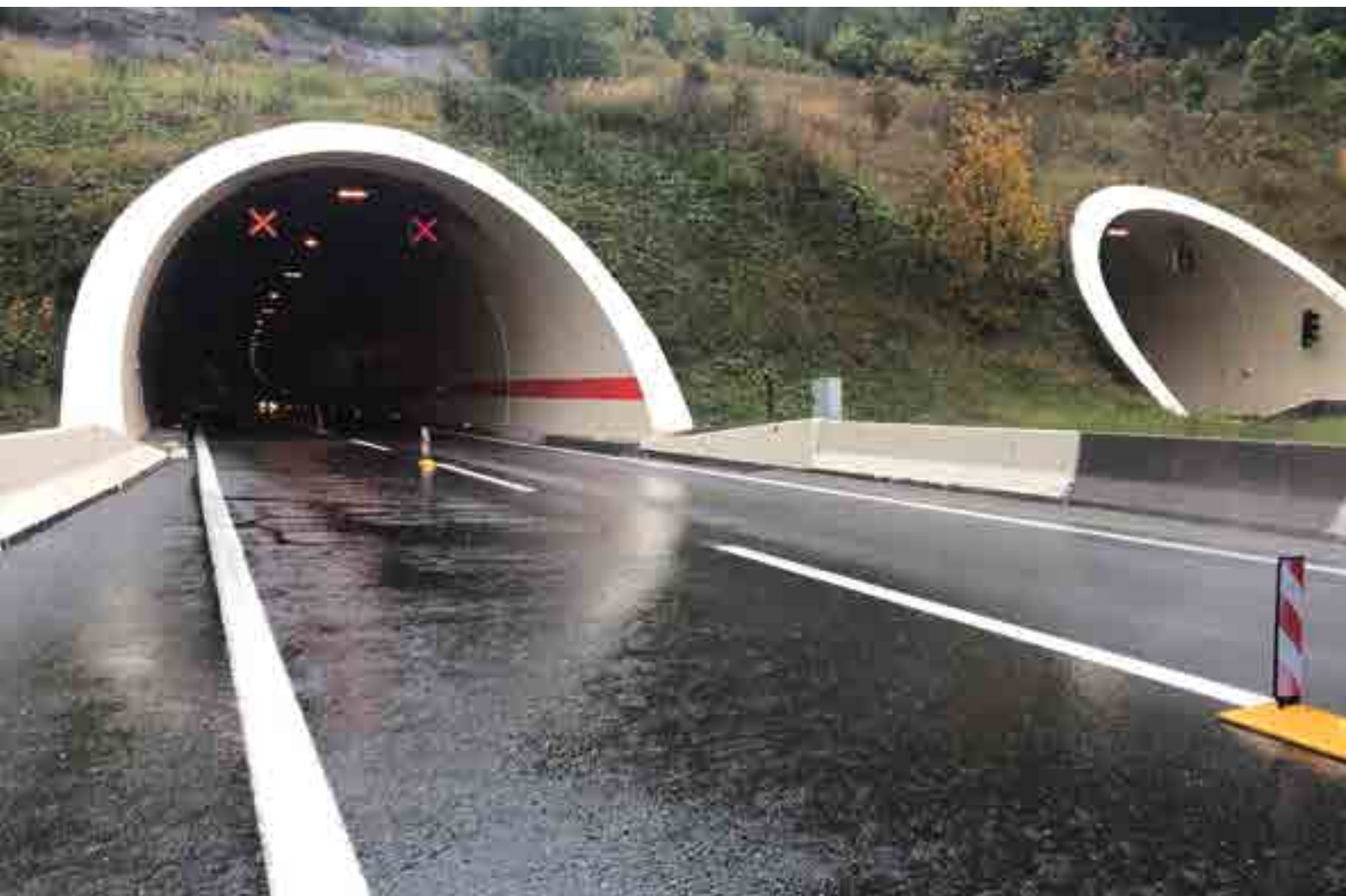
lokacija: tunel Ledenik
