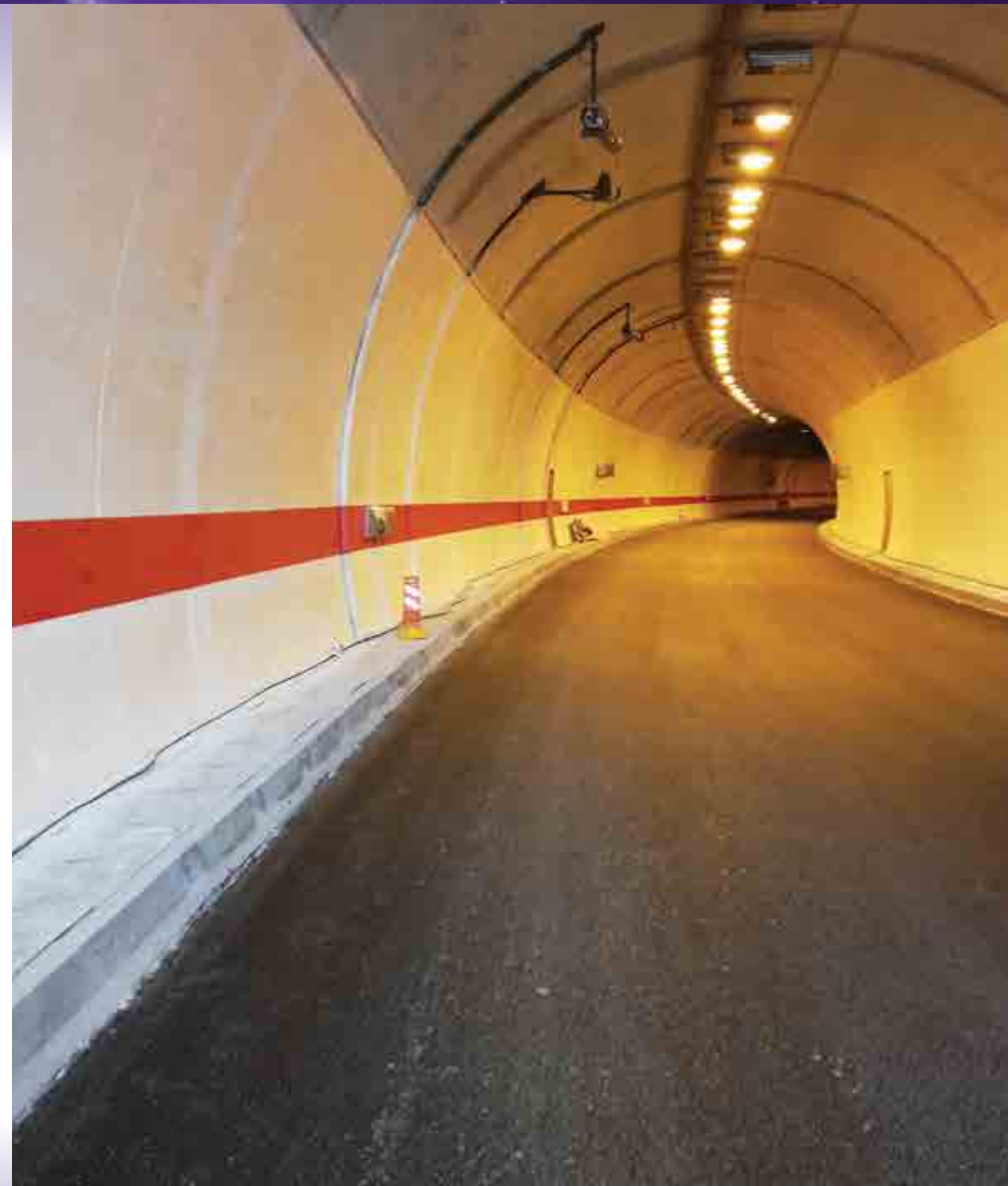
lokacija: tunel Ledenik
